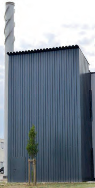
Abb. 28: Außenlager (70 t), bestehend aus zwei Gewebesilos mit Einhausung
